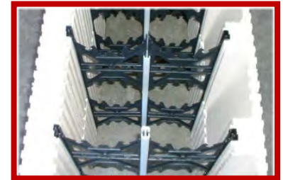
Agrafe en H joint deux entretoises de 6" (15.2cm) illustré = 12.63" (32.07cm) largeur de béton
